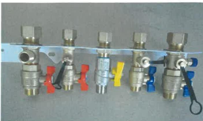
Rimontare il raccordo gas sulla barra rubinetti allineando la farfalla della valvola gas con quelle dei rubinetti acqua
